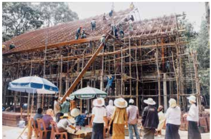
ระหว่างก่อสร้างพระอุโบสถวัดป่าภาคินิมิตต์
